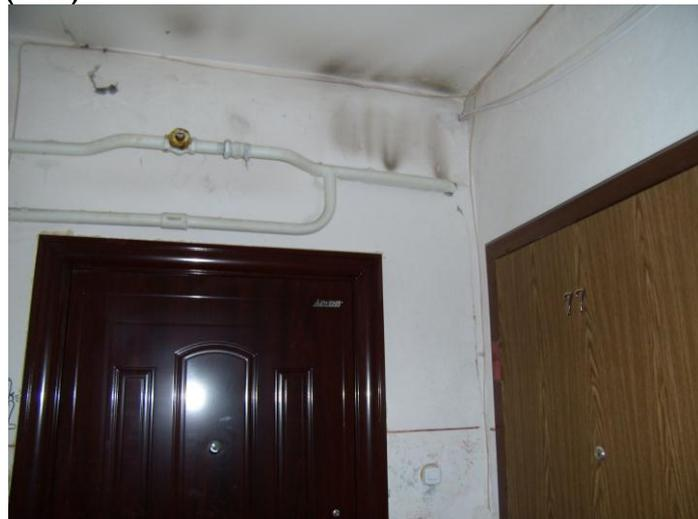
Горизонтальний трубопровід із гарячою водою в коридорі квартири, який прикріплено на висоті 2,25 метри від полу безпосередньо до міжквартирних стін
