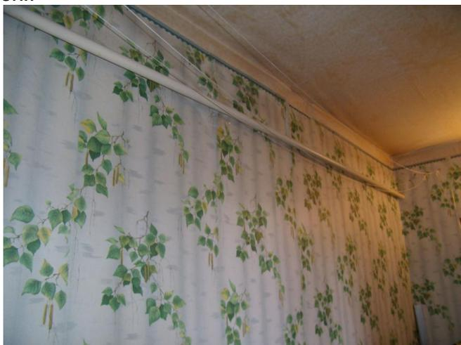
Горизонтальний трубопровід із гарячою водою переходить в стояк гарячої води, який заведений в ванну кімнату замість рушникосушильника
